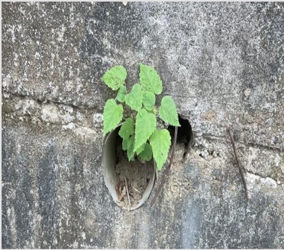
擋土牆上排水孔多處堵塞
